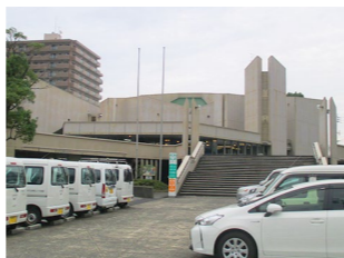
2016 久留米市民会館解体前見学会
